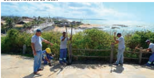
Foto dos trabalhos de manutenção Fonte: SECOM, 2015.
