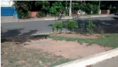
As vias cicláveis não possuem acessos às vias perpendiculares, reduzindo as conexões e induzindo o tráfego na contramão.
