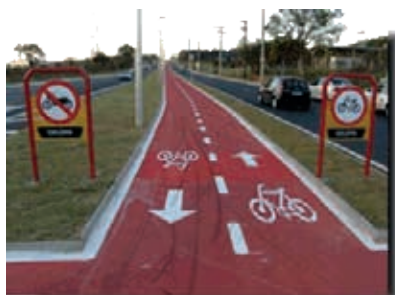
Obstáculos e sinalização de proibido tráfego de motocicletas e indicação para bicicletas.
