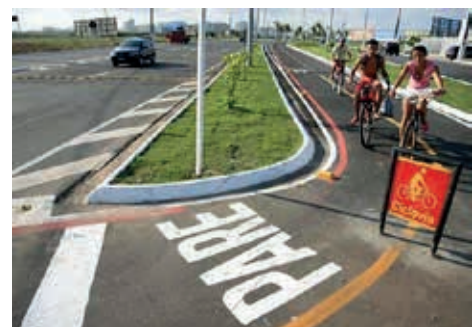
Obstáculo e sinalização para redução da velocidade do ciclista e parada obrigatório. Impedimento à entrada de outros veículos.
