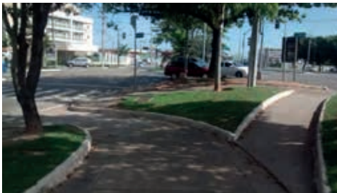
As vias pedonais e vias cicláveis se fundem sem canalização e sem sinalização.
