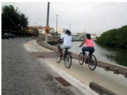
Avenida Linda, às margens do Rio das Ostras
