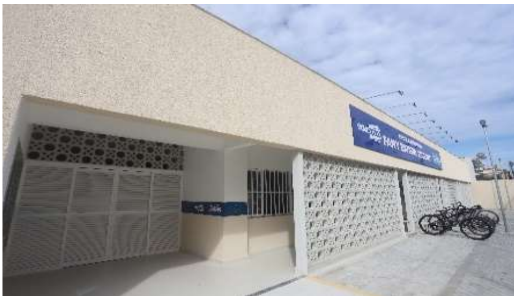
Reforma ampliação da Escola Fany Batista
