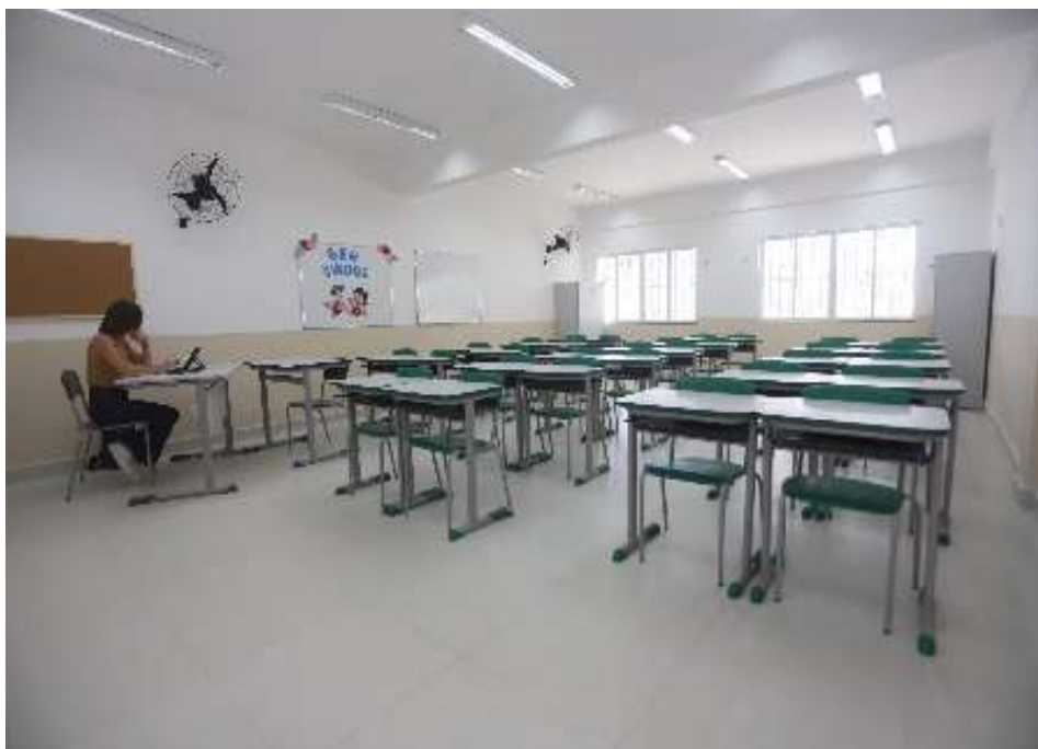
Reforma ampliação da Escola Fany Batista
